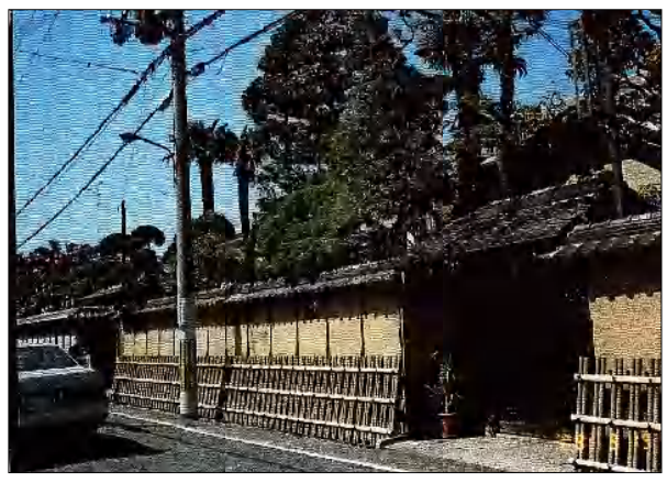
日本通り玉井町に残る屋敷45年のアメリカの空襲によりほとんどの屋敷が壊滅した。
